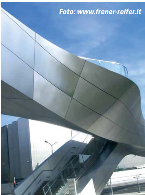
Habillage métallique d'éléments de mur d'un pont d'autoroute à TOKYO, formé sur une machine Kraftformeur ECKOLD.
