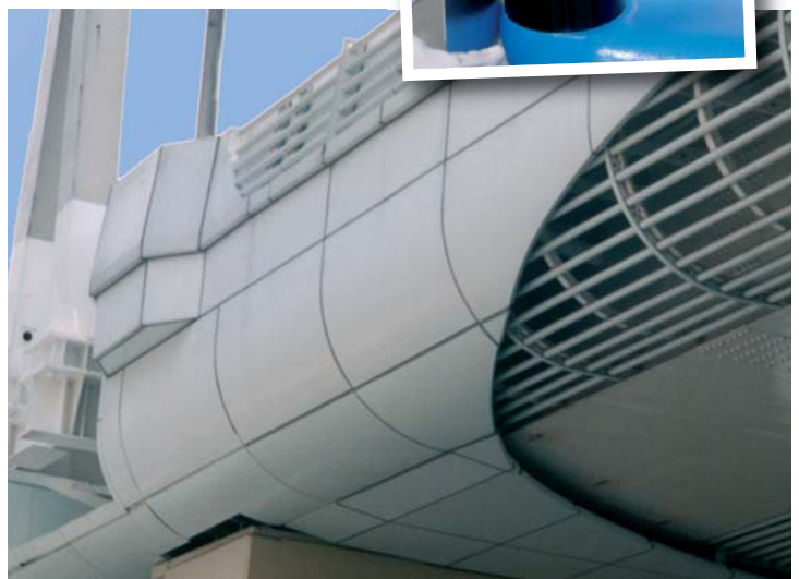
Habillage métallique d'éléments de mur d'un pont d'autoroute à TOKYO, formé sur une machine Kraftformeur ECKOLD.
